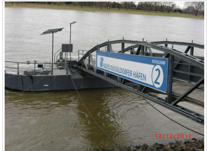
Solarbeleuchtung Piers im Köln-Düsseldorfer Hafen Special application: Solar lighting of the piers in the Koeln-Duesselder Harboure.
